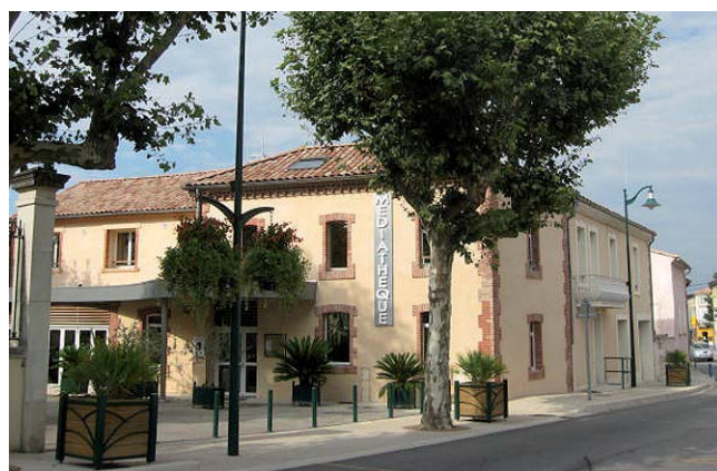
Médiathèque de Châteaufort-du-Rhône 2 316 habitants - 336 m 2 / Architecte : S. Flandin
