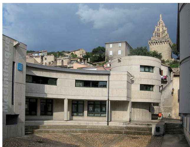
Agora extérieure Médiathèque départementale Drôme provençale à Nyons Architectes : C. Royer et D. Chapuis
